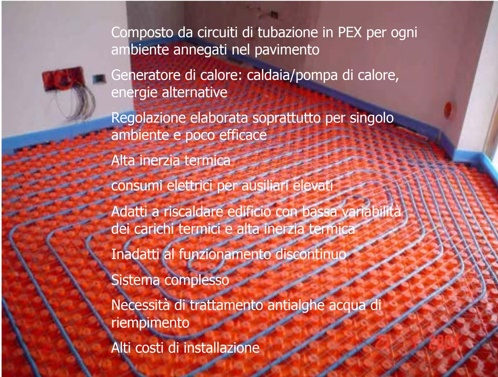
Composto da circuiti di tubazione in PEX per ogni ambiente annegati nel pavimento
